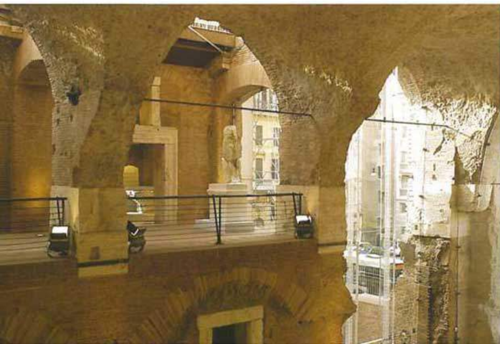
In basso, a sinistra Chiusura con vetrate in metacrilato della Sala dei Mercati Traianei, Impresa Clax Italia.
